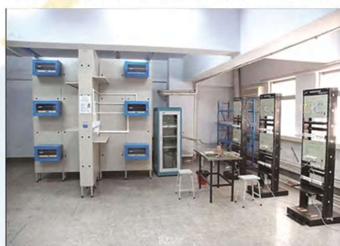
综合布线实训室
